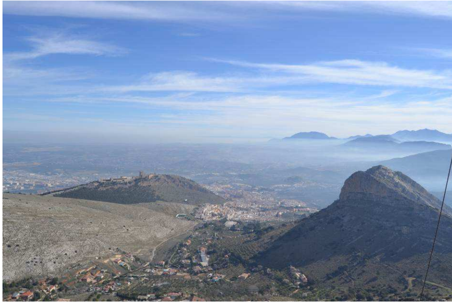
Vista del Castillo de Santa Catalina desde el cerro de La Mella. Fuente: propia.
